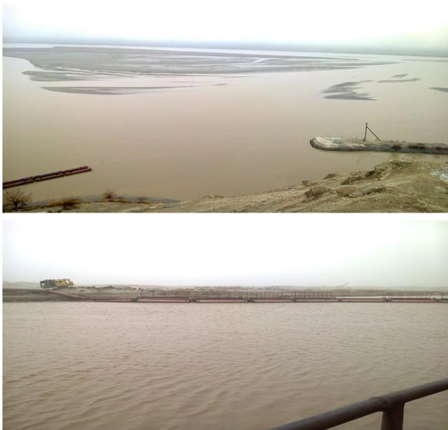
Рис.1 – Запань на водозаборе КМК из реки Амударья
