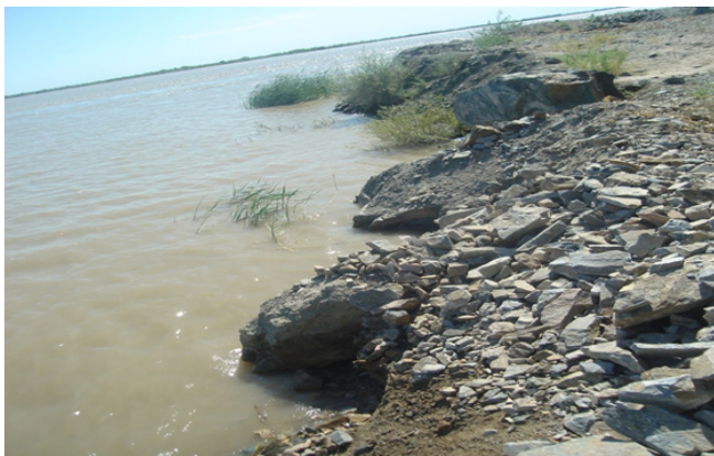
2-расм. Амударёда жойлашган №145 дамбанинг қуйи томонининг ювилиши
