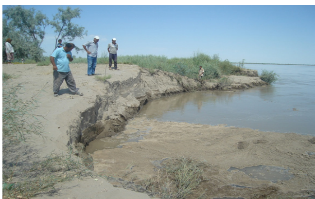
3-расм. Амударёда жойлашган №21 дамбанинг қуйи томонининг ювилиши
