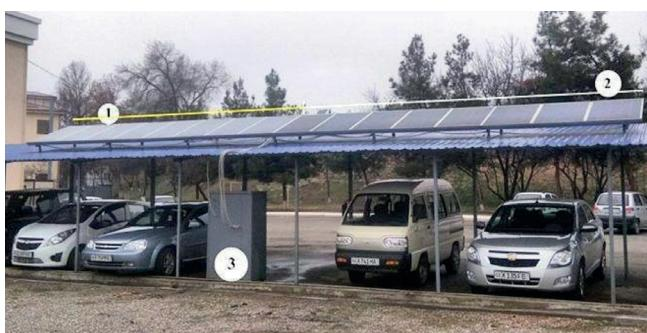
1- фронтальная защита из стекла с рифленой поверхностью, 2-из стекла с полированной поверхностью, 3-блок управления и контроля установки.
