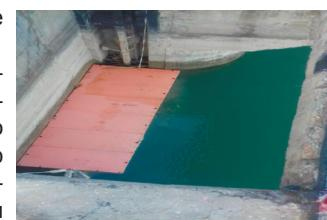
Рис.2. Поверхностная направляющая потокоформирующих элементов
