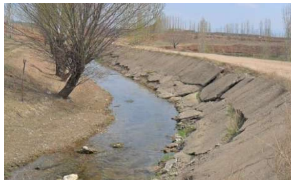
2-расм. Сув чиқарувчи сув тўсиш иншооти ва Ғалаба каналининг ҳолати
