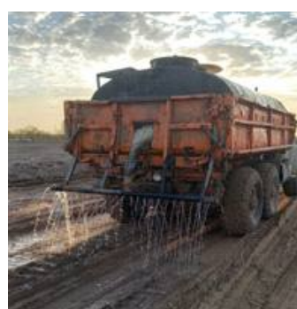
Рис. 7. Увлажнение грунта
