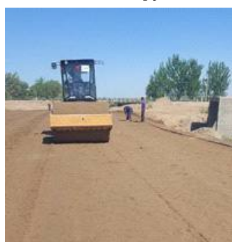
Рис. 8. Уплотнение виброкатками
