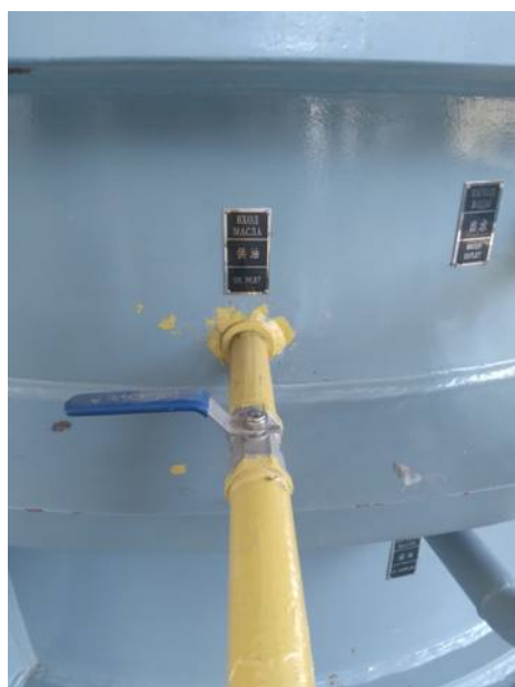
Рис. 3. Трубопроводы технического обеспечения электродвигателя (подача масла и отвод технической воды)
