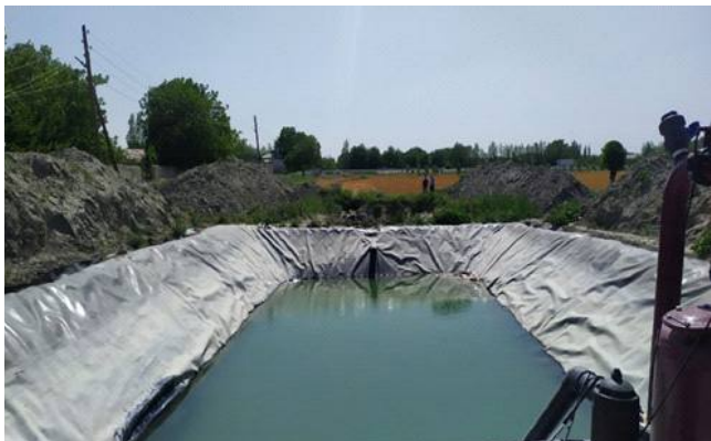
1-расм. “Қоратери Ботир пахтаси” фермер хўжалигидаги томчилатиб суғориш тизимидаги мембранали тиндиргич
