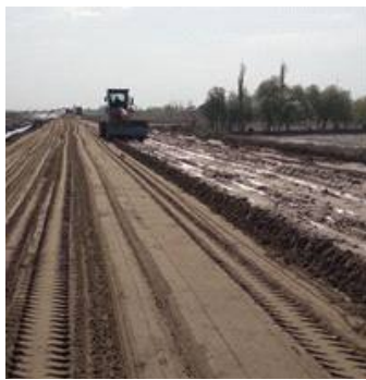
Рис. 6. Разравнивание грунта
