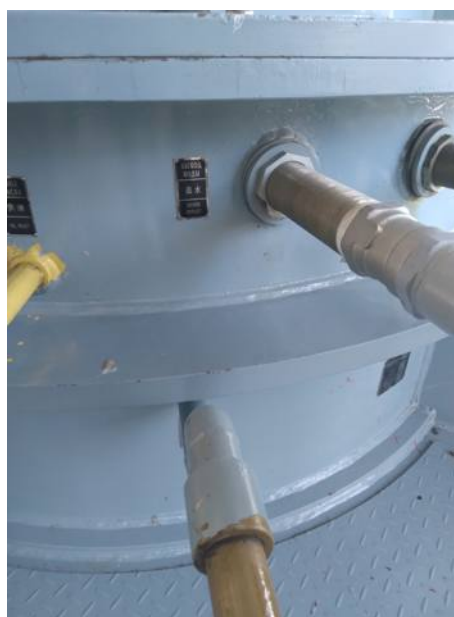
Рис. 3. Трубопроводы технического обеспечения электродвигателя (подача масла и отвод технической воды)
