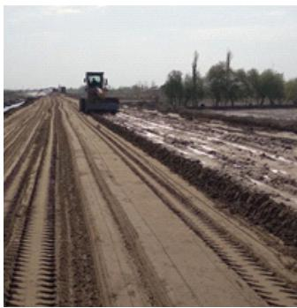
Рис. 6. Разравнивание грунта
