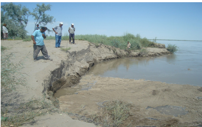
3-расм. Амударёда жойлашган №21 дамбанинг қуйи томонининг ювилиши
