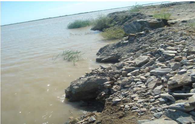
2-расм. Амударёда жойлашган №145 дамбанинг қуйи томонининг ювилиши
